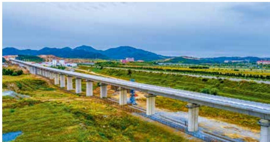
潍烟高铁西藏家黄河特大桥
