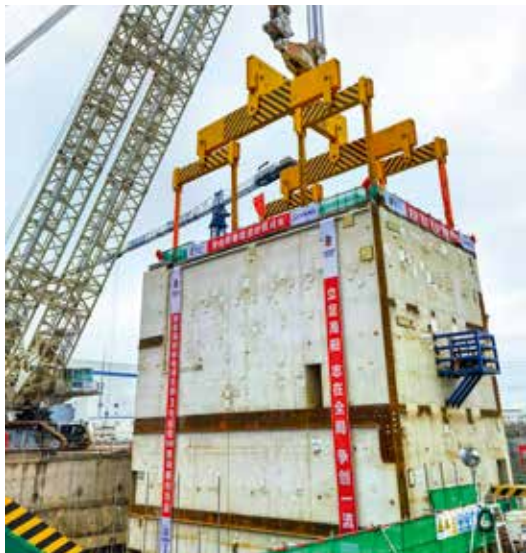
2022年8月29日，海阳核电3号机组核岛最重结构模块CA20顺利吊装就位（海阳市 供图）
