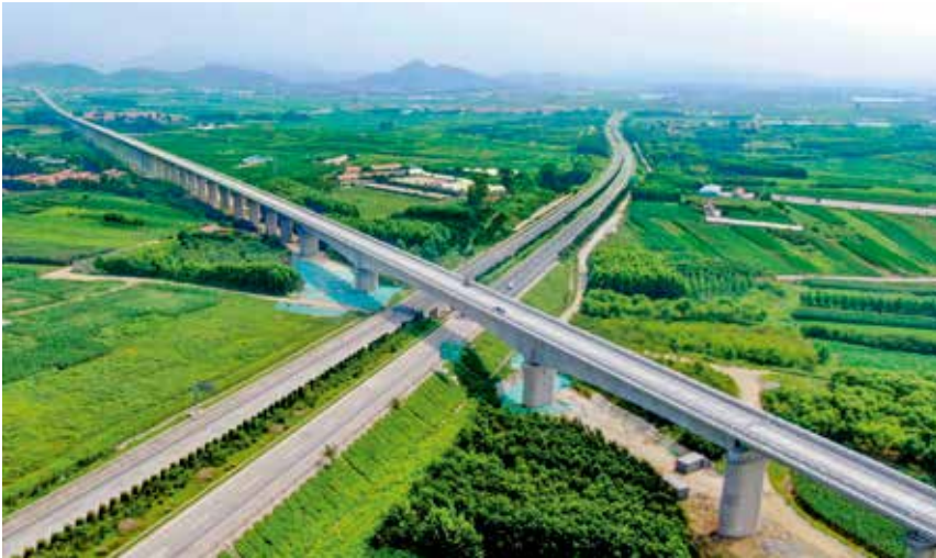
莱荣高铁跨烟海高速特大桥
