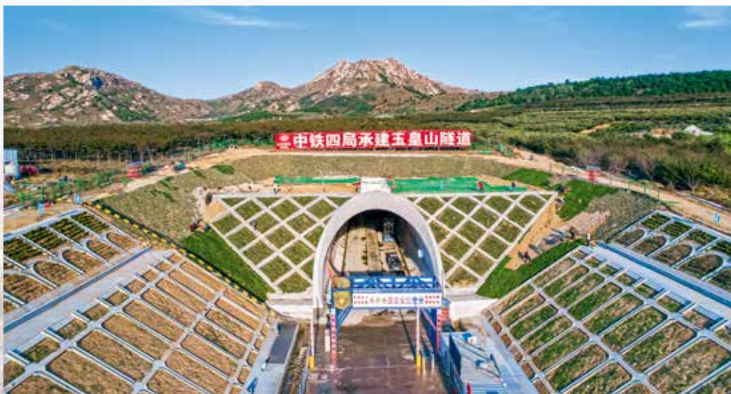
2022 年 6 月 29 日，莱荣铁路最长隧道——玉皇山隧道进口至斜井段贯通。至此，莱荣高铁全线隧道全部贯通（市交通运输局 供图）
