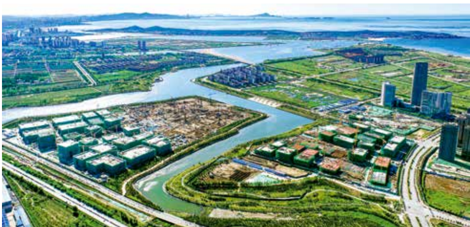
2022 年 1 月 16 日，蓝色药谷·生命岛一期项目开工建设（牟平区供图）
