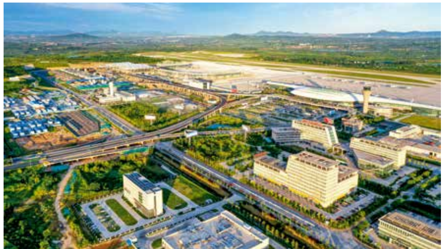
2022年10月31日,烟台机场二期工程高架桥项目通过验收,较合同工期提前136天竣工 (张炳庆 摄)
