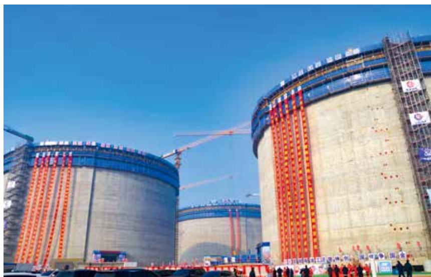
2021 年 9 月，中国石化龙口 LNG 项目和国家管网两大央企主导的龙口两大液化天然气项目开工（龙口市 供图）
