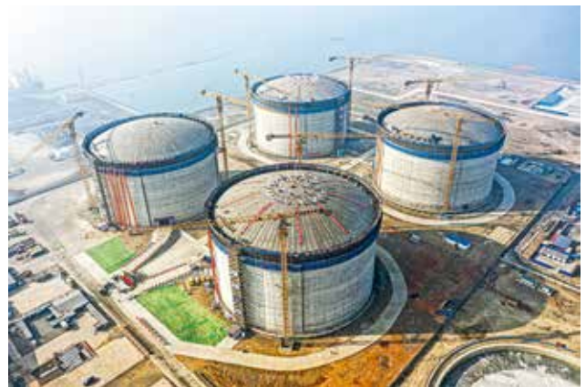
2021 年 12 月 15 日，国家管网集团龙口南山 LNG 接收站项目一期工程储罐气顶升活动举行（市发展改革委 供图）
