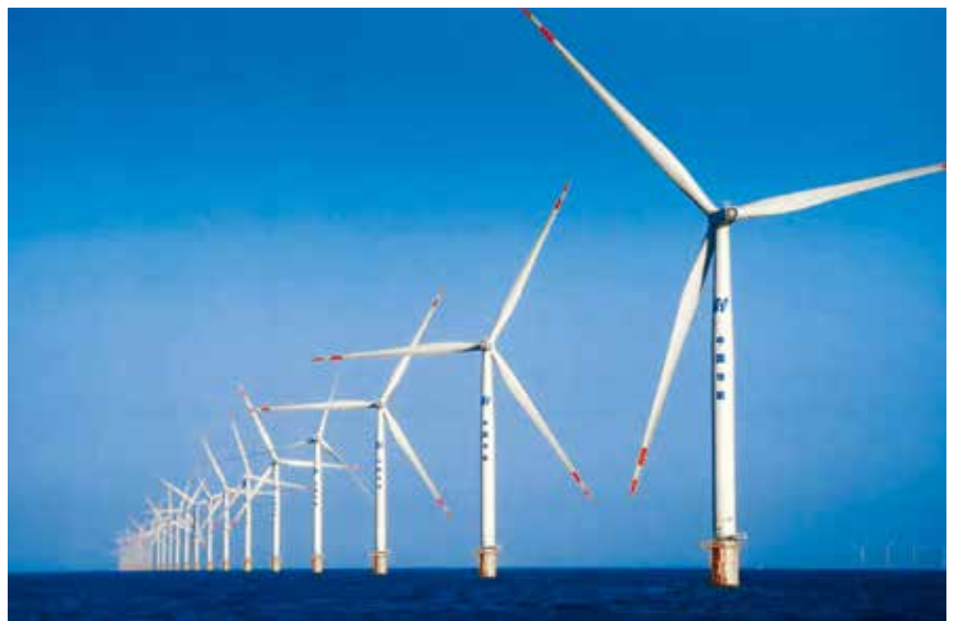
2021 年 9 月 12 日，华能山东半岛南 4 号海上风电项目，首批风电机组顺利并网，发出山东省第一度海上风电（海阳市 供图）
