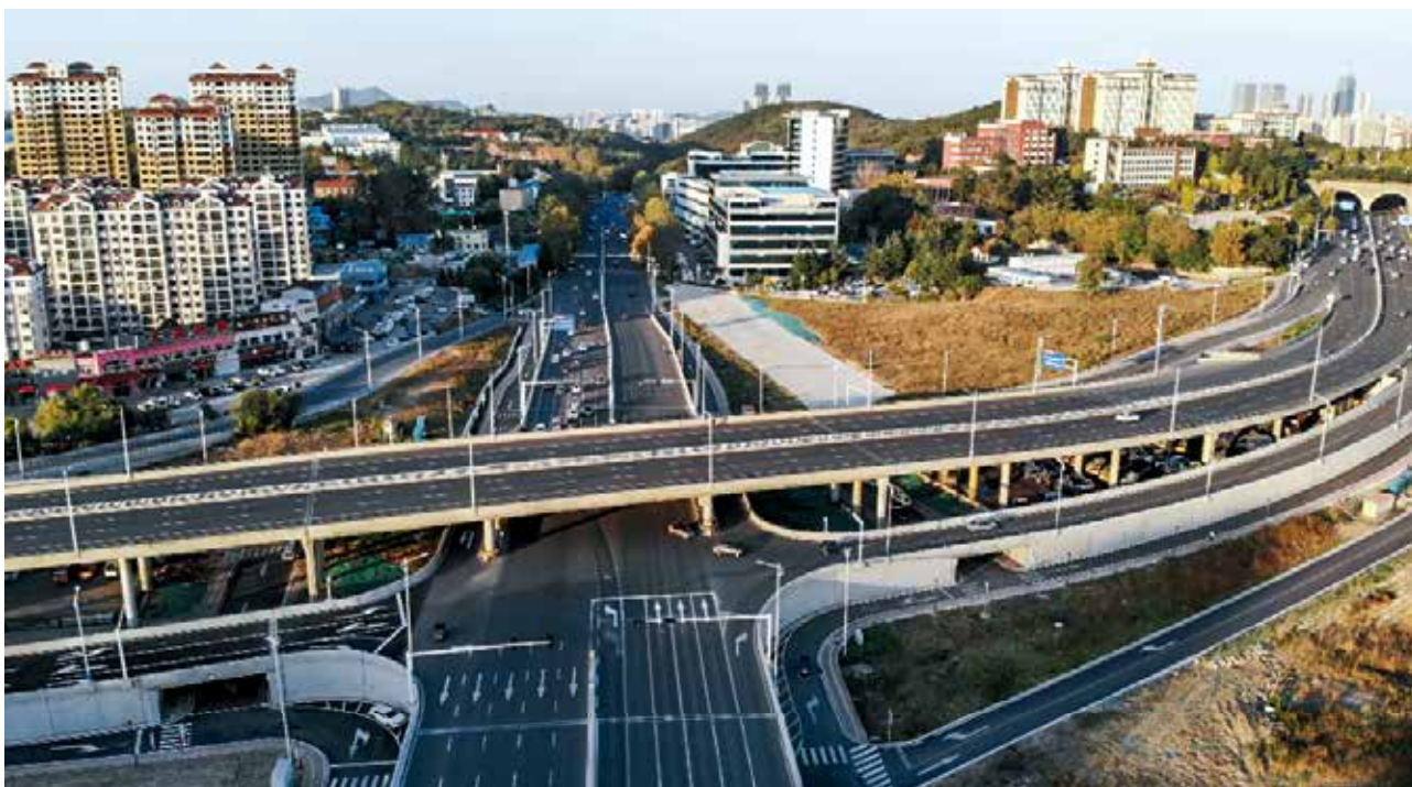
2021 年 10 月 29 日，烟台机场路立交桥续建工程竣工通车（市住房城乡建设局 供图）
