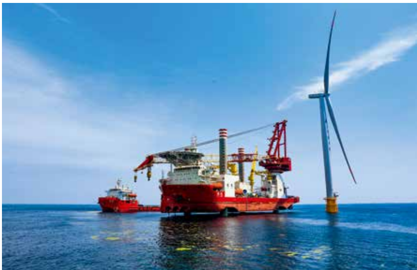
2021年6月23日,烟台海事局为华能山东半岛南4号海上风电项目34号风机并网提供保障 (烟台海事局 供图)
