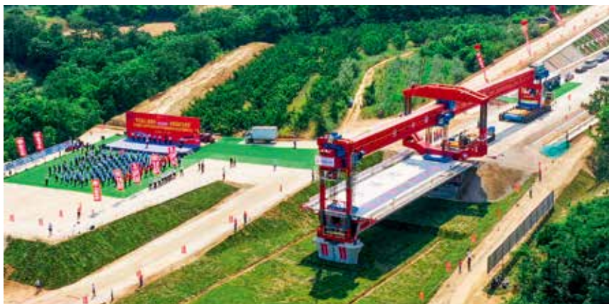
2021年6月26日，潍烟高铁全线首榀箱梁在烟台市蓬莱区刘家沟镇吕家沟村成功架设，标志着烟台高铁建设全面进入架梁阶段（市交通运输局 供图）
