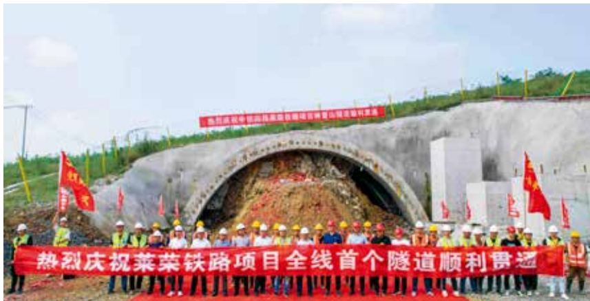
2021年9月12日，莱荣高铁首个隧道——神童山隧道全线贯通
