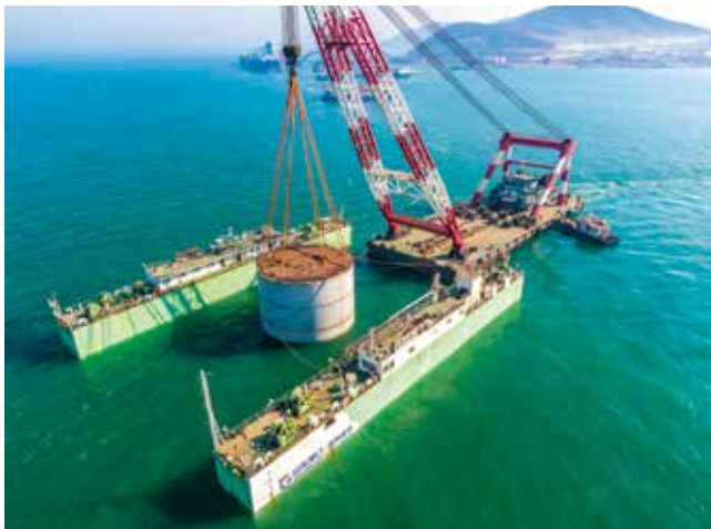
2021 年 10 月 18 日，烟台港西港区原油码头二期工程开工建设（烟台港 供图）
