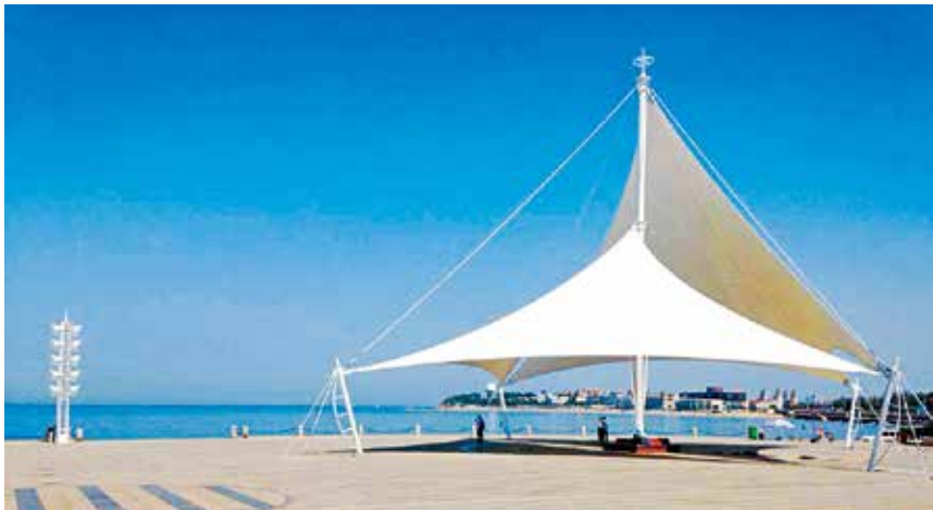
整修一新的海韵广场
