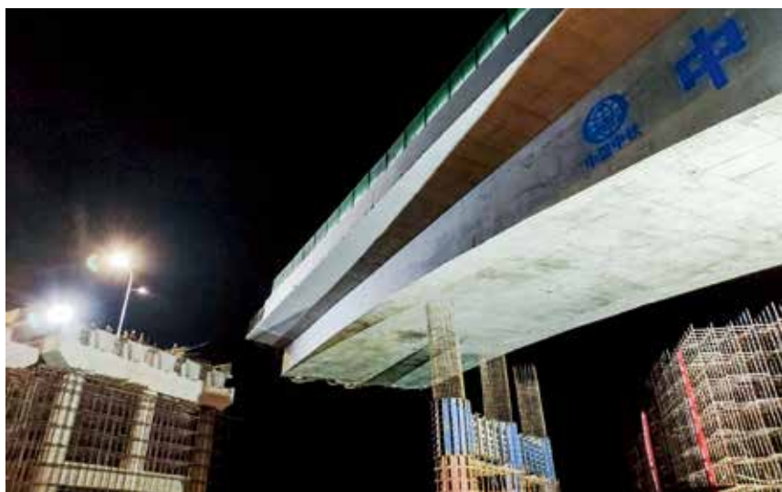
2019年12月30日，跨蓝烟铁路立交桥工程正式通过验收，并获2019年烟台市政工程施工标准化示范工地荣誉称号。该工程是烟台城建史上第一座转体桥，10月16日完成主桥转体（供稿：刘津宇）
