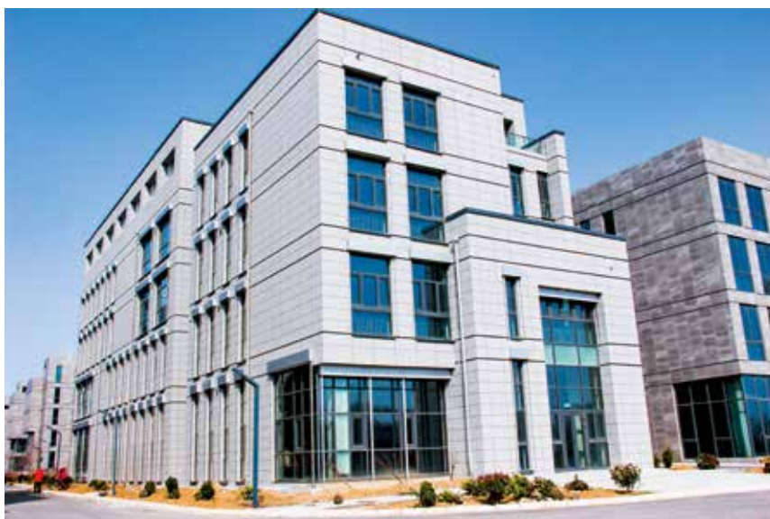
2019 年 11 月 6 日，烟台北航科技园 28 号楼在第十八届中国国际住宅产业暨建筑工业化产品与设备博览会被动式超低能耗绿色建筑技术交流大会上获被动式超低能耗绿色建筑质量标识 (供稿：刘津宇)
