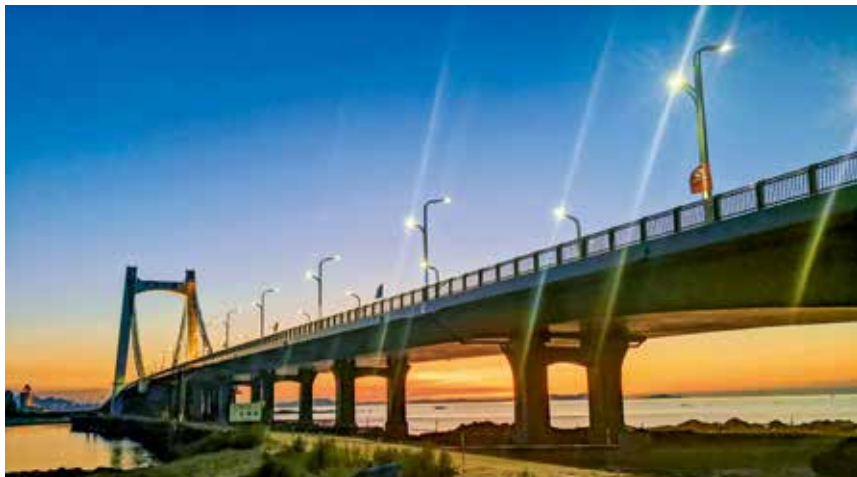
2019年6月5日,滨海西路及夹河桥项目通过住房和城乡建设部“市政公用科技示范工程”验收,标志着夹河桥工程继获第十三届第二批“中国钢结构金奖”后又添一项国家级荣誉 (供稿:刘津宇)
